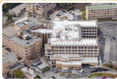
新棟GH棟建築
